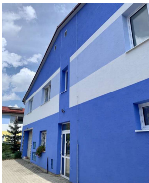
Hala po rekonštrukcii.
