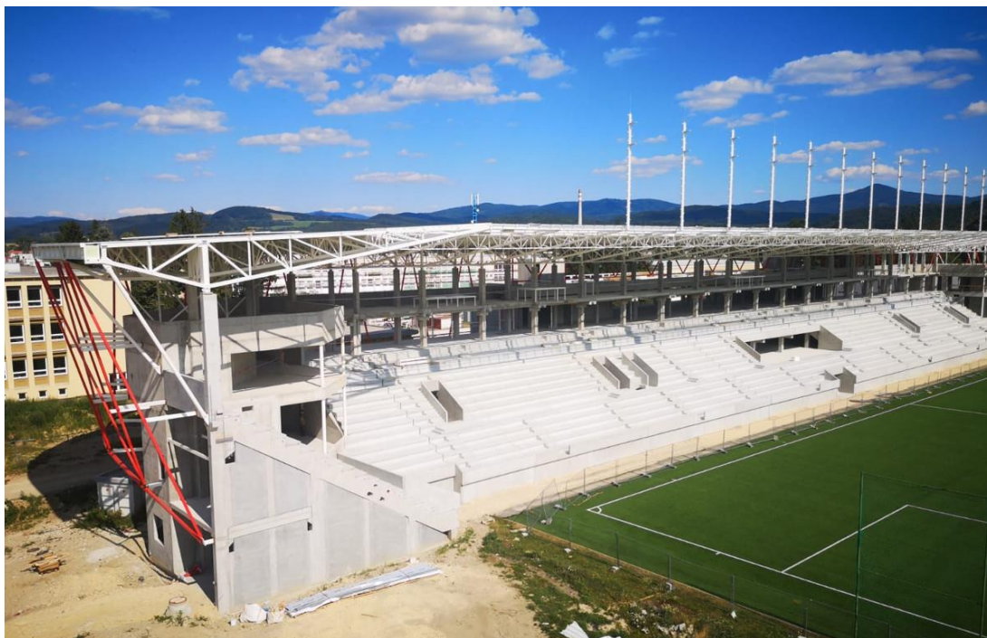
Výstavba futbalového štadióna v Trenčíne.
