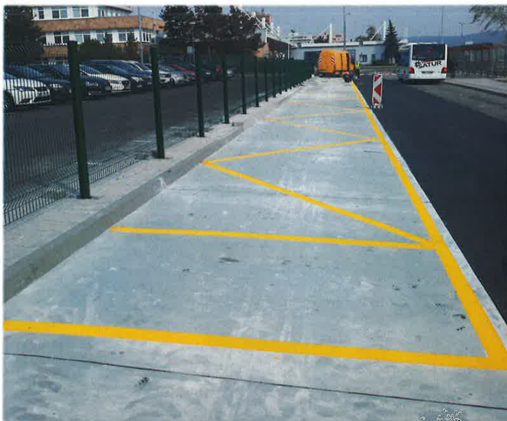
Devínska Nová Ves – kompletne zhotovenie spevnených plôch
