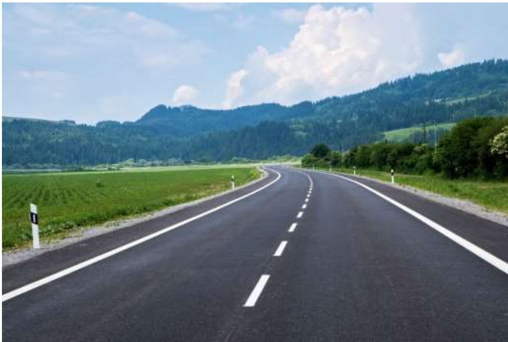
stavba: I/68 Plavnica, preložka cesty
