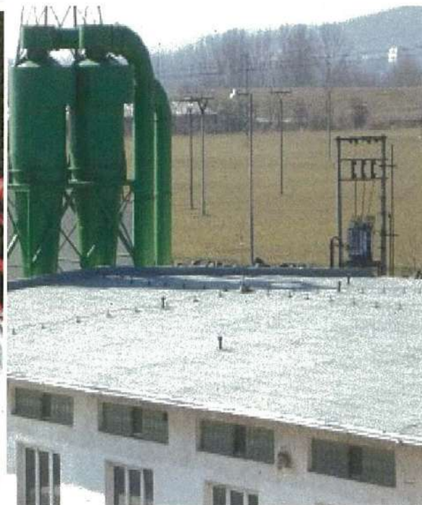
Oprava strechy Beluša
