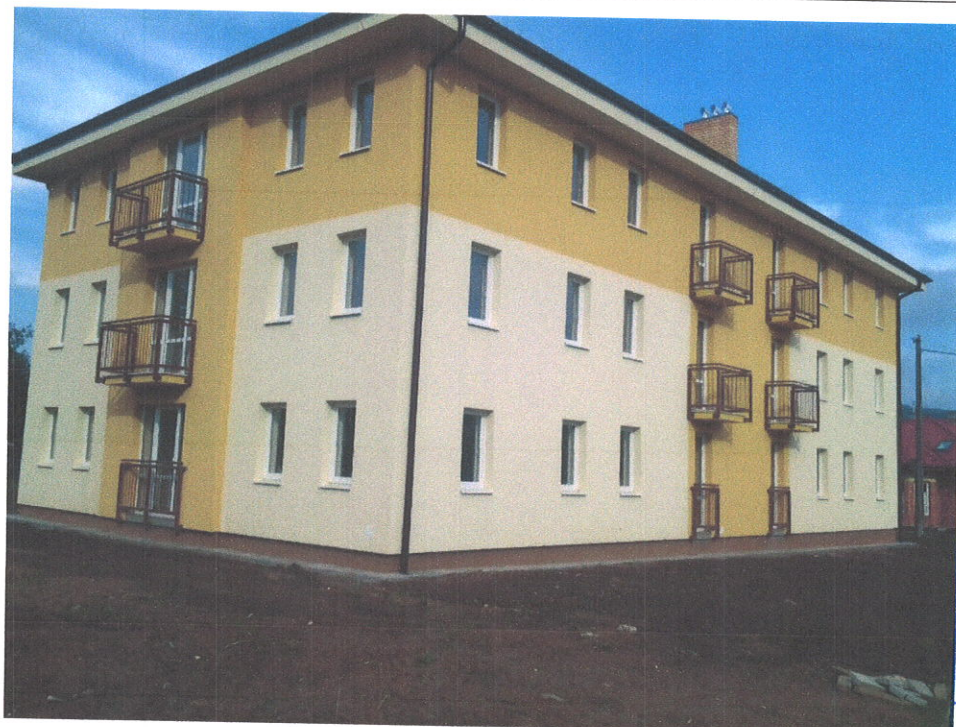
Bytový dom 12 b.j. Bystré
