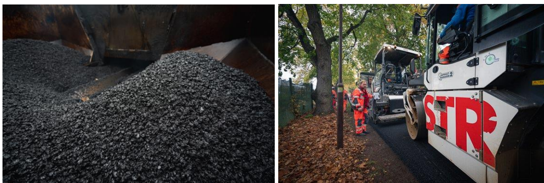
Asfaltová zmes s obsahom spracovaných cigaretových filtrov a pokládka asfaltovej zmesi pri výstavbe prvého pokusného úseku asfaltovej komunikácie v Žiari nad Hronom
