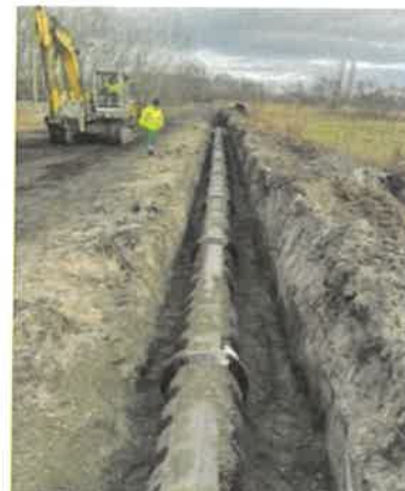
Rekonštrukcia kanalizácie Plavecký Štvrtok
