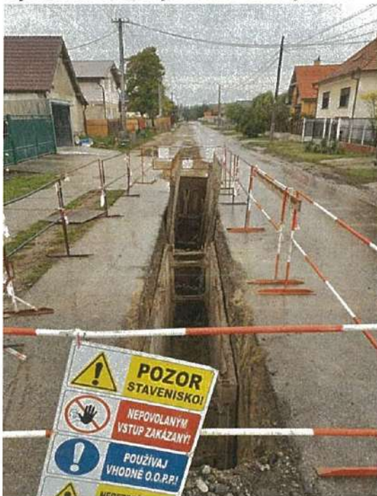
Kanalizácia Lúč na Ostrove
