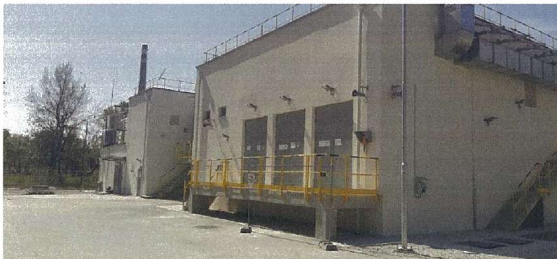
Slovnaft a.s – Výstavba etylénovej nádrže – časť Trafostanica
