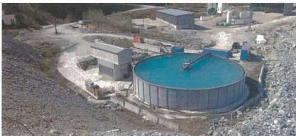
Mechanicko-chemická ČOV na východnom portáli tunela Višňové
