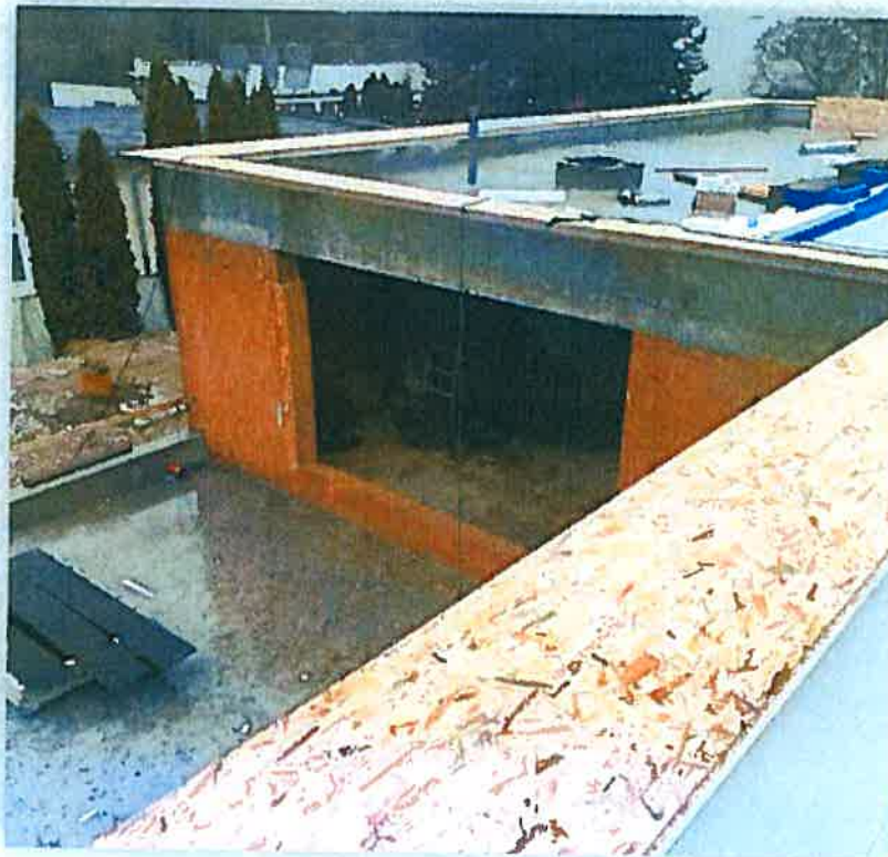
Obr. 1 Novostavba Materská škola Teplická, Bratislava
