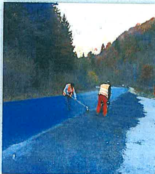
Obr. 6 Rekonštrukcia cesty II/583 k. ú. Párnica
