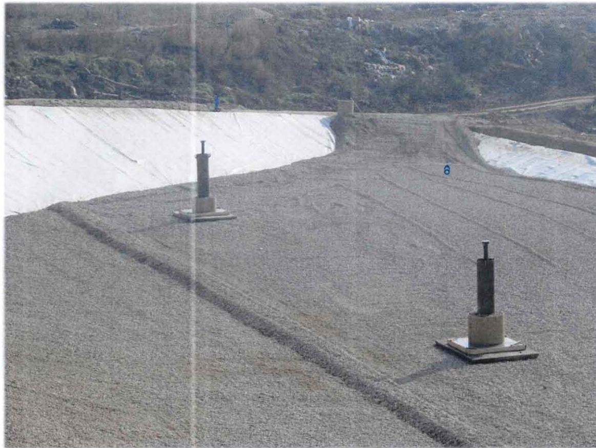
BOJNÁ – skládka odpadov, časť C – 2. etapa
