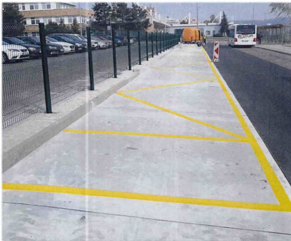
Devínska Nová Ves – kompletne zhotovenie spevnených plôch
