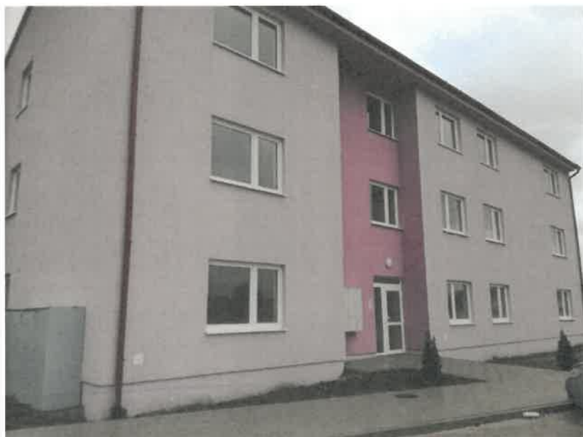
Bytové domy – Dolný Bar, 24 bytových jednotiek, r. 2018 - 2019
