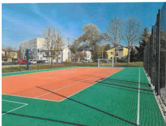
Rekonštrukcia viacúčelového ihriska – Oravská cesta
