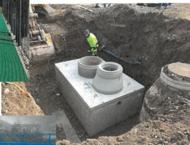
Výstavba rozvodov pre plyn a kvapaliny Šport Park – Pltníky – I. etapa, Martin
