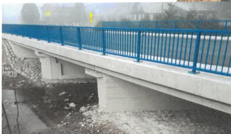
Rekonštrukcia cesty II/487, mostné objekty, Časť 1 - Mostné objekty ev.č. 487/ 038, 039, 042 a Časť 2 - Mostné objekty ev.č. 487/ 044, 048, 061, 064 - Žilinský kraj
