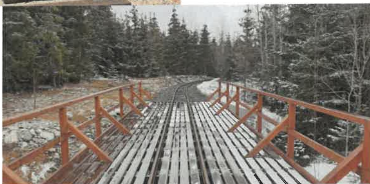
Liptovské múzeum v Ružomberku - MLD Pribylina - úprava trasy Považskej lesnej železnice
