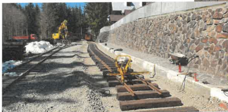
Oprava výhybiek v stanici Beskyd - Oravská lesná železnica
