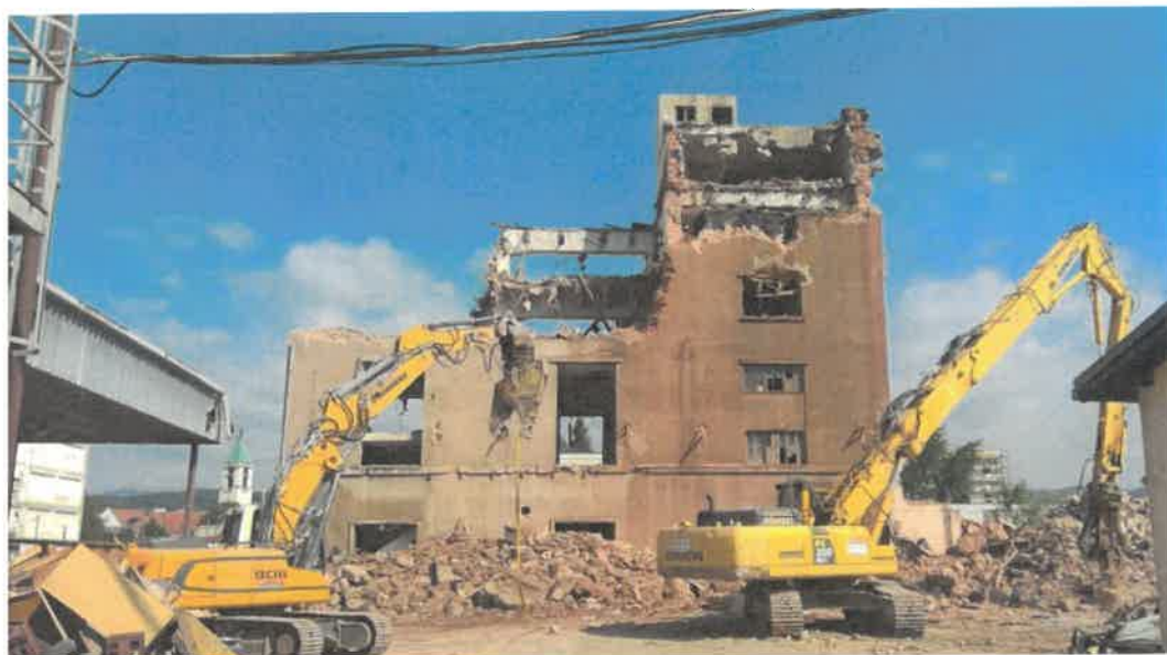
Asanácia stavby s.č.1240 - Varňa, kotelňa - Pivovar Bytča
