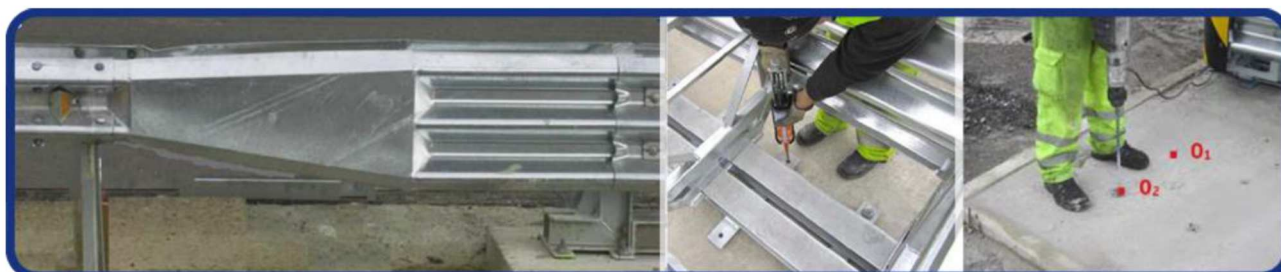
Montáž a osádzanie záchytného bezpečnostného zariadenia – tlmiče nárazu (zvodidlá).
