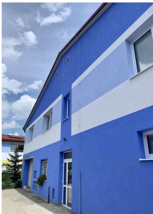
Hala po rekonštrukcii.
