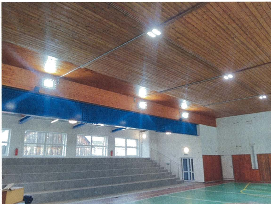
Foto č. 5 - Rekonštrukcia telocvične ZŠ v obci Kamienka
