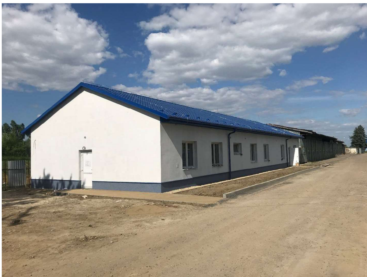
Administratívna budova VVS, Trebišov (2021)
