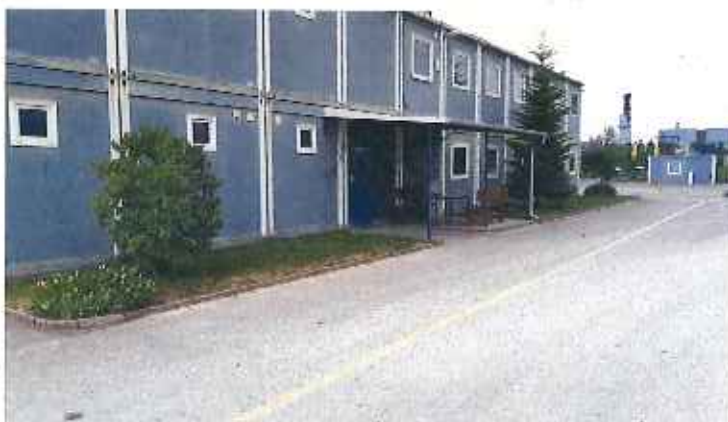
Trávnaté plochy pri prevádzkovom objekte Obal'ovne Veľká Ida
