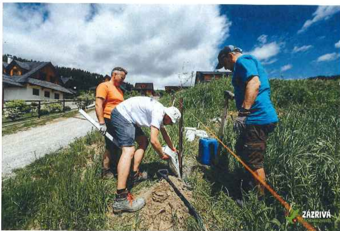
Betonáž plotových stĺpikov
