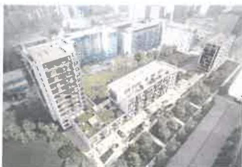
Bytový dom Sebrínho ulica, Bratislava
