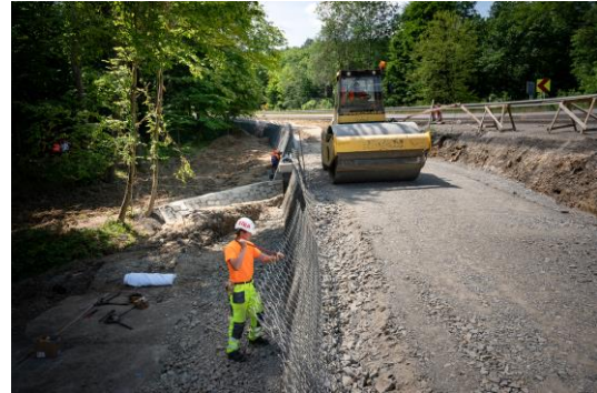
Rekonštrukcia Hanušovce (Direkcia TG)
