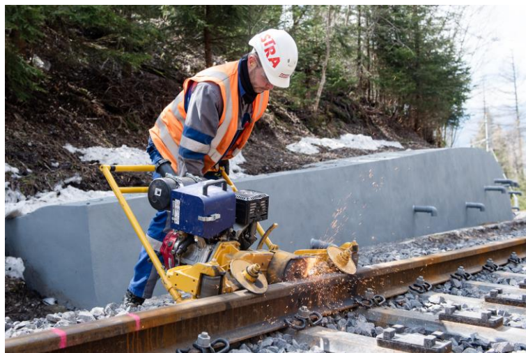
Rekonštrukcia ozubnicovej železnice Štrba – Štrbské Pleso (Direkcia TJ)
