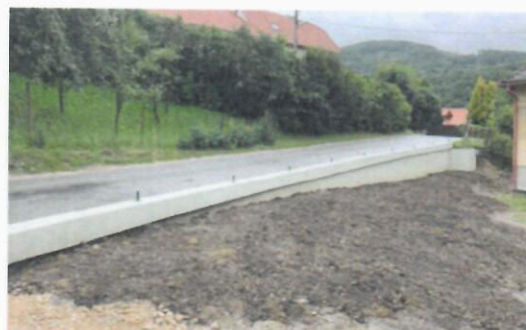
Sanácia zosuvu na ceste vybudovaním oporného múru a príľahlej cestnej komunikácie v obci Kováčová.
