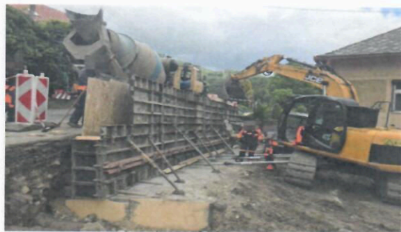
Sanácia zosuvu na ceste vybudovaním oporného múru a príľahlej cestnej komunikácie v obci Kováčová.
