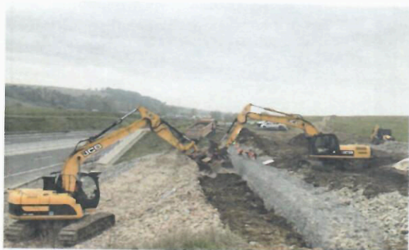
Stabilizácia svahu po zosuve s komplexným riešením odvodnenia.
