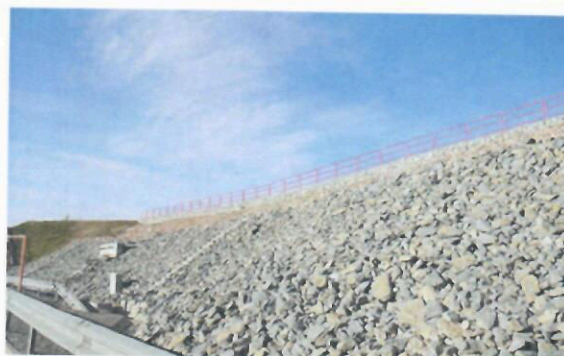
Stabilizácia svahu po zosuve s komplexným riešením odvodnenia.
