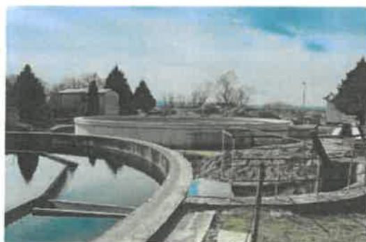
Obr.č. 5 - 6 Realizácia ČOV
