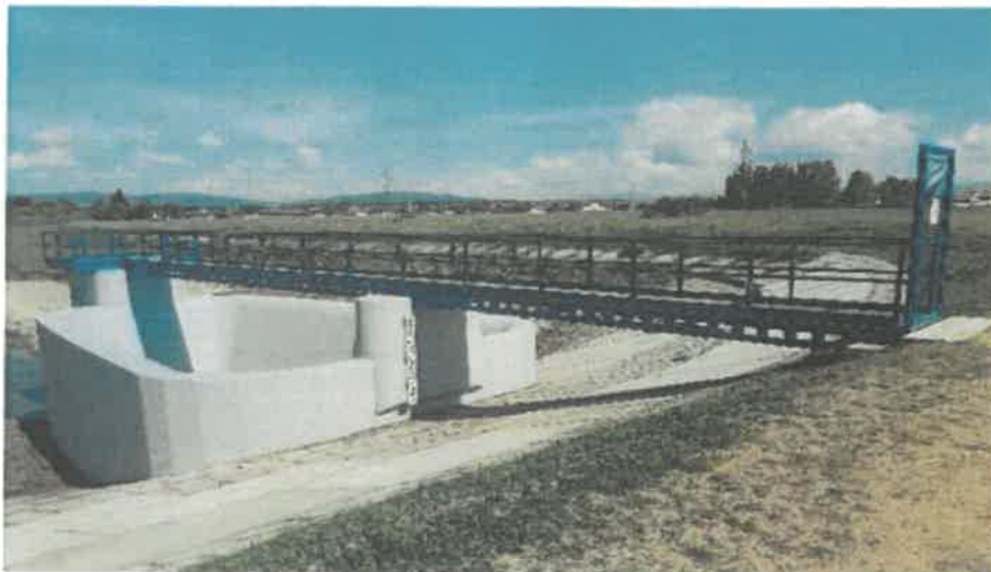
Obr.č. 14 Vodné dielo Ladovo ,rekonštrukcia bezpečnostného priepadu
