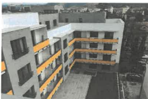
Obr.č.2-4 Realizácia- Pozemné stavby
