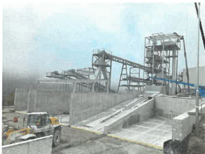
Úprava mastenca Gemerská Poloma
