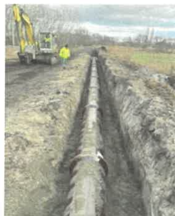
Rekonštrukcia kanalizácie Plavecký Štvrtok
