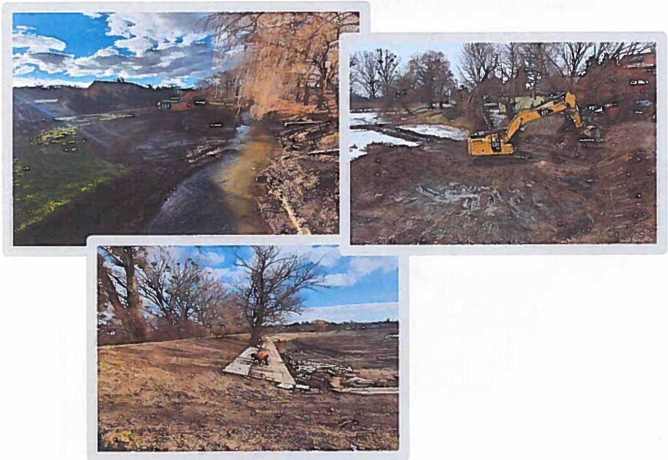
Obr. 5 Rybník DNV – rekonštrukcia viacúčelovej vodnej nádrže
