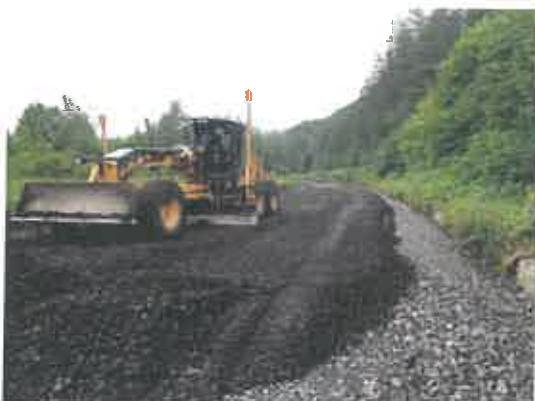
Predvený recyklát bol v súlade s požiadavkami objednávateľa späťne zabudovaný do konštrukčných vrstiev vozovky resp. do nespevnených krajníc, čím sa predišlo vzniku značného množstva odpadu.
