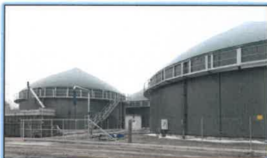
Stavba bioplynová stanica
