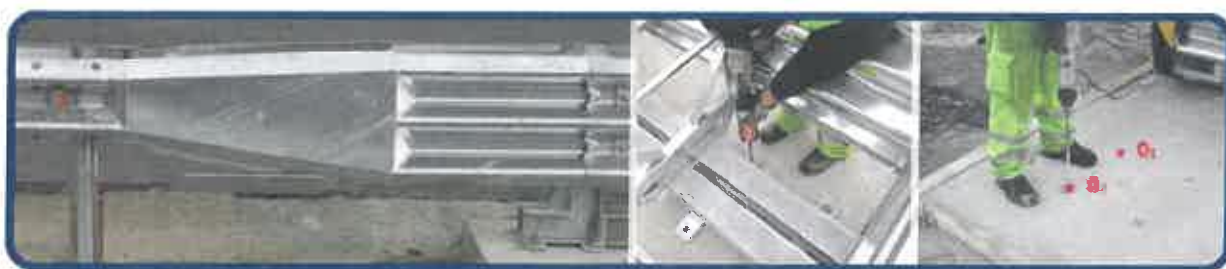
Montáž a osádzanie záchytného bezpečnostného zariadenia – tlmiče nárazu (zvodidlá).
