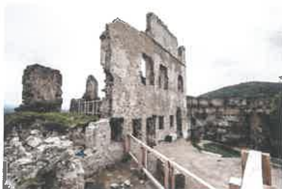
Považský hrad: V rámci sprístupnenia národnej kultúrnej pamiatky verejnosti sme realizovali statické zabezpečenie múrov a osadenie prvkov náučného chodníka.
