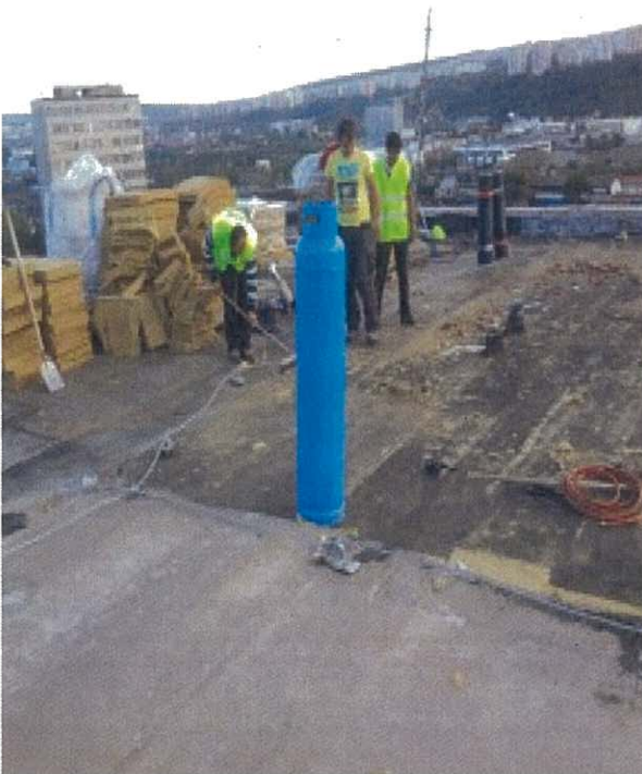
Rekonštrukcia strešného plášt'a budovy Úradu práce, sociálnych vecí
