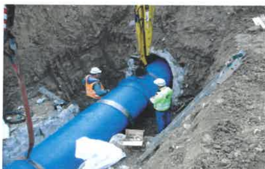
Obr.č.18-21- Oprava prívodného potrubia Nitrianske Rudno-bezvýkopová metóda (montáž potrubia v svahovanej jame)
