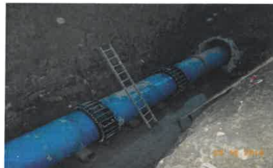
Obr.č.18-21- Oprava prívodného potrubia Nitrianske Rudno-bezvýkopová metóda (montáž potrubia v svahovanej jame)
