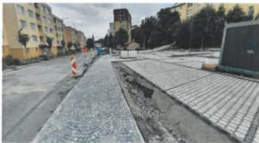
Obr.č.11-15- Realizácia- kanalizácie; ČOV, vybudovanie parkoviska
