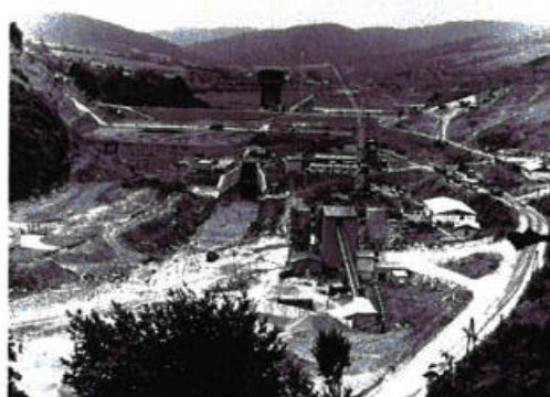
Obr. 3 - Vodárenská nádrž Starina
