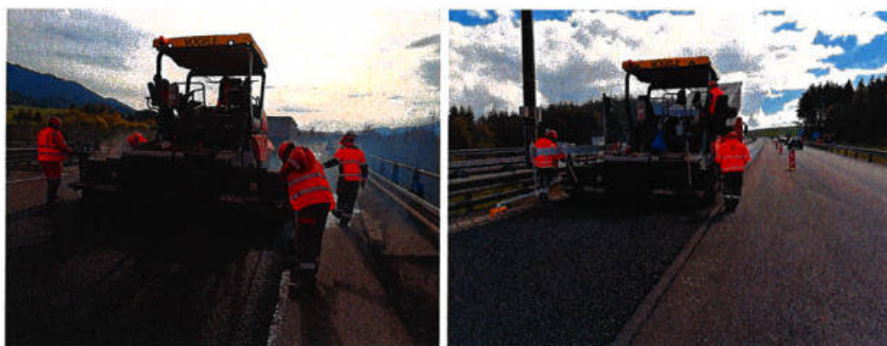
Obr. 4, 5 – Opravy na D1, Mengusovce
