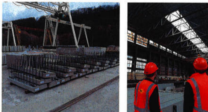
Obr. 8, 9 - Prefa Kysak – výroba železobetónových prefabrikovaných konštrukcií
