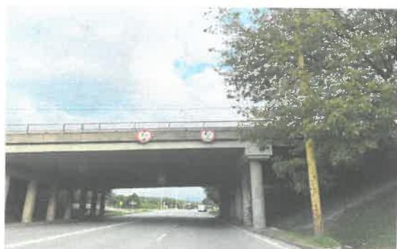
Reprofilácia mostných nosníkov stredného pola mosta s doplnením výstuže najviac poškodených nosníkov.
