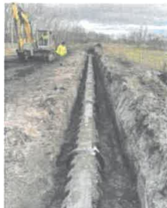
Rekonštrukcia kanalizácie Plavecký Štvrtok
