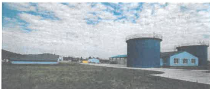
Kráľovský Chlmec - kanalizácia a ČOV
