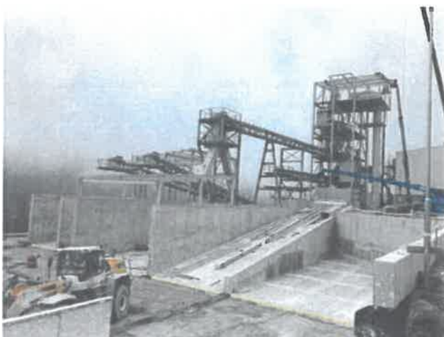
Úprava mastenca Gemerská Poloma
