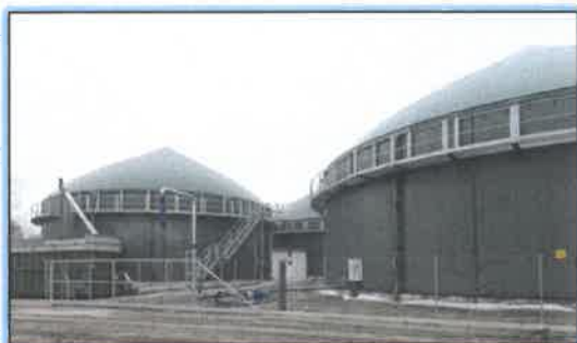
Stavba bioplynová stanica
