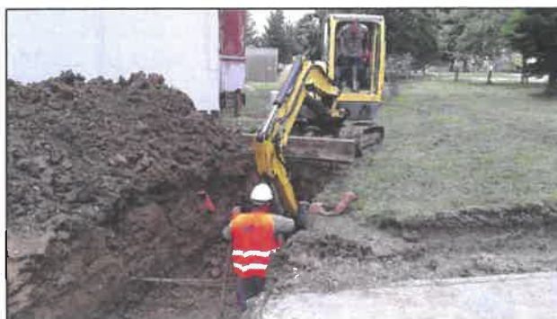
Stavba TEHO Košice rozvody
