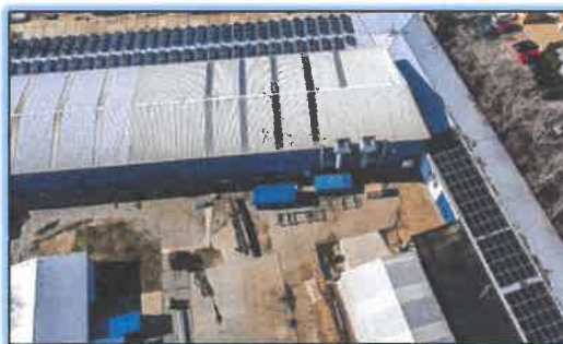
Slnečné kolektory a vykurovanie
