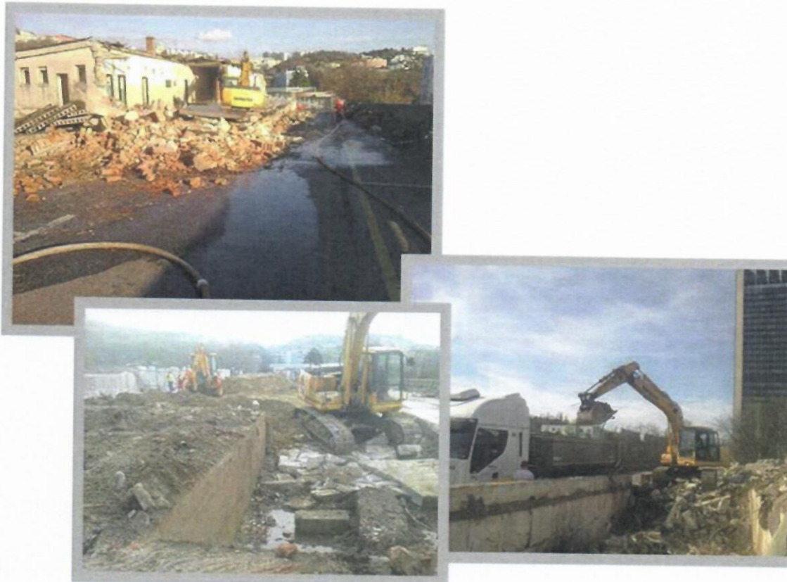
Obr. 2 Demolácia budovy RTVS Bratislava
