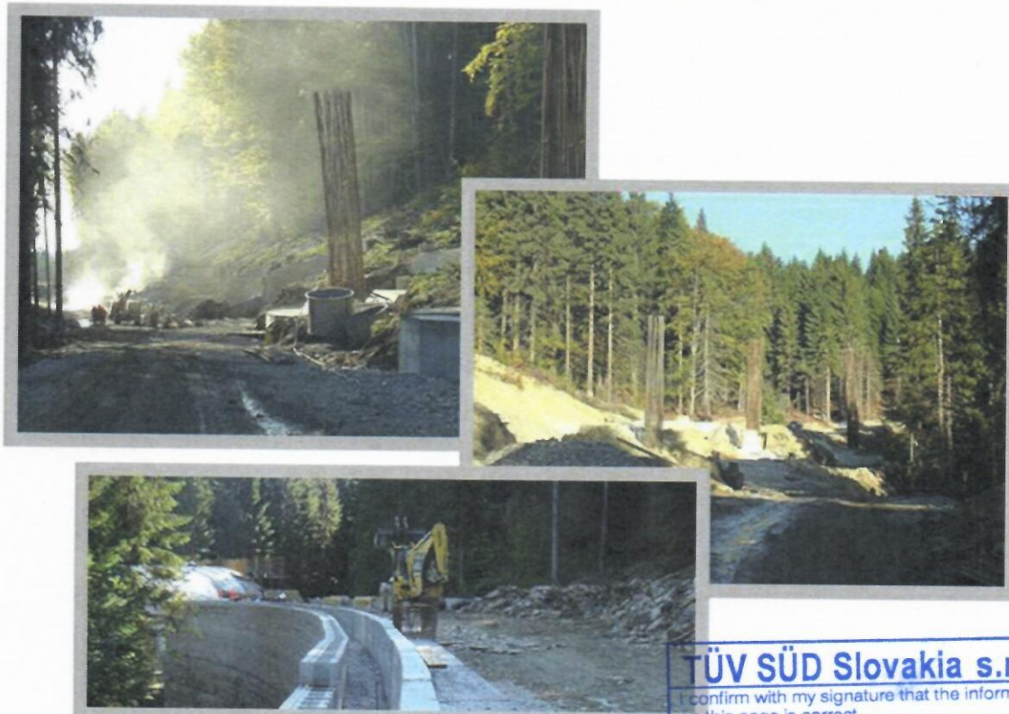
Obr. 3 Lesná cesta Oravská Lesná - Zázrivá
