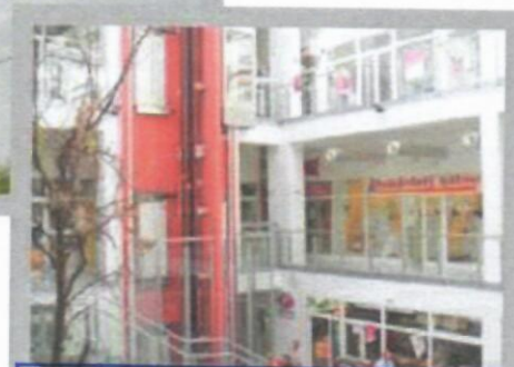
Obr. 1 Kompletná realizácia Polyfunkčného domu Klince, Namestovo
