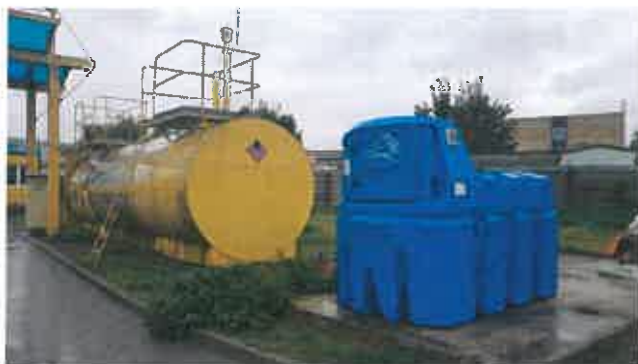
Zakúpili sme a inštalovali kontajner na AdBlue, dvojplášťová nádrž o objeme 2500 litrov, vrátane výdajných stojanov, na ekologické skladovanie a vydávanie prípravku AdBlue do vozidiel a strojov.
