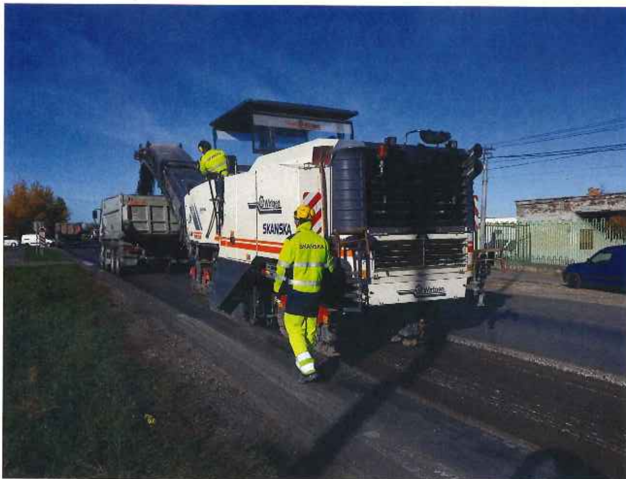
Asfaltové úpravy v obci Trnovec nad Váhom
