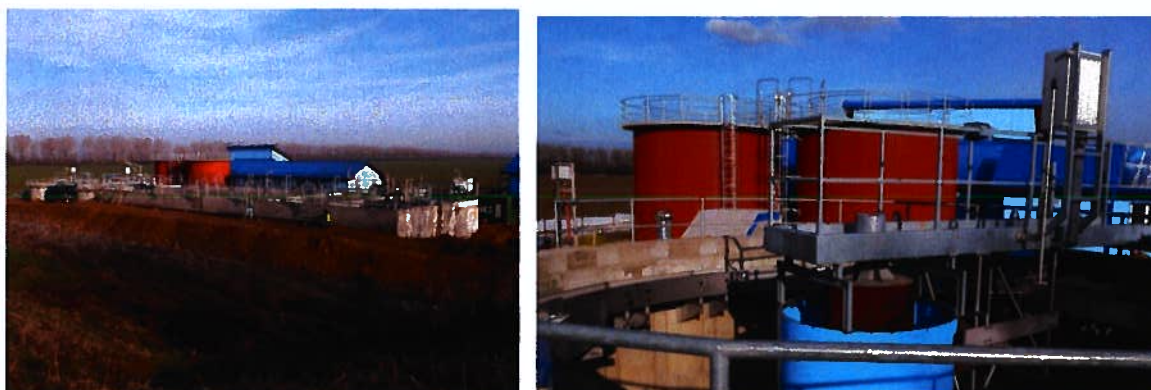
Obr. 18, 19 - Trhovište, Bánovce nad Ondavou, kanalizácia a ČOV
