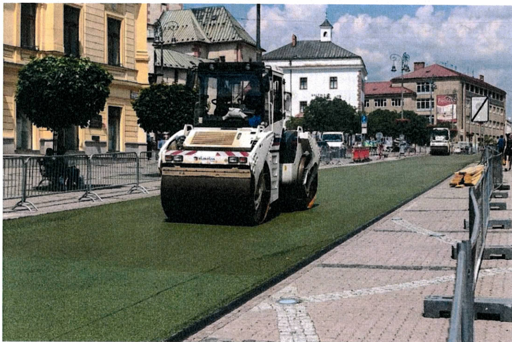
Pokládka zeleného asfaltu v meste Banská Bystrica
