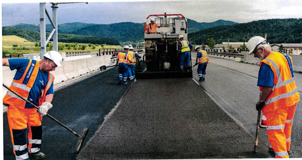
Pokládka emulzného mikrokerca GRIPFIBRE na D1 Behárovce
