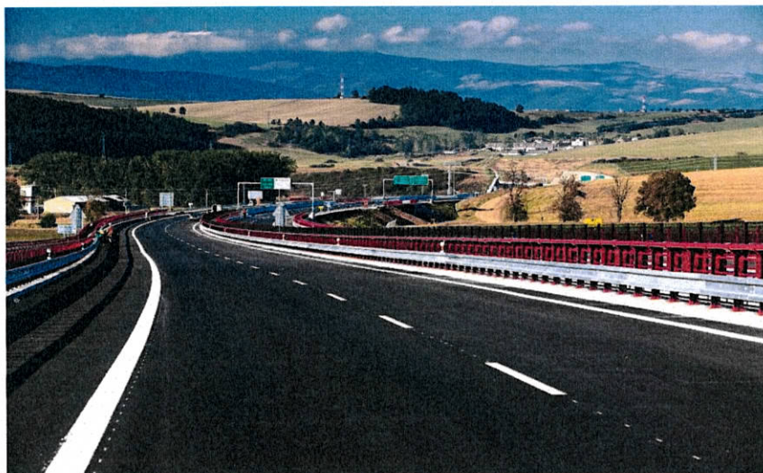
Stavba Diaľnica D1 v úseku Janovce - Jablonov
