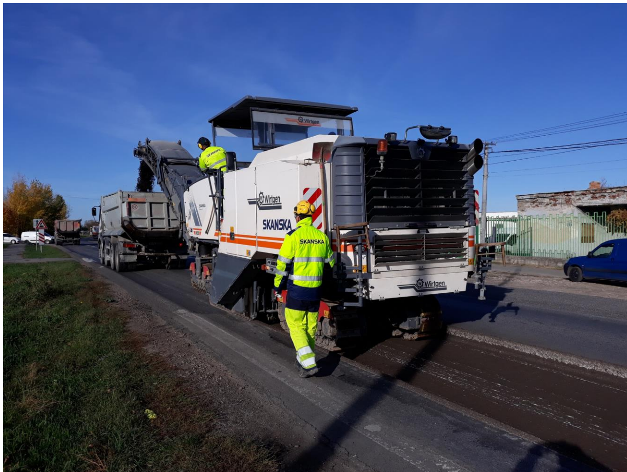
Asfaltové úpravy v obci Trnovec nad Váhom
