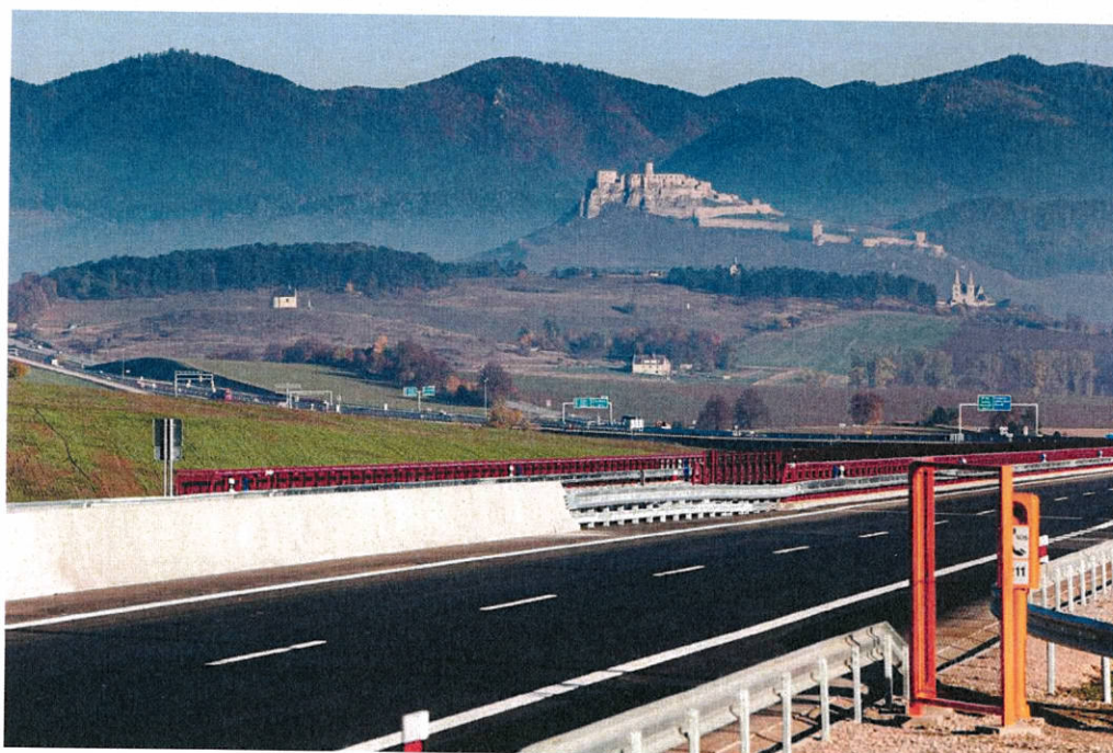
Diaľnica D1 v úseku Jánovce – Jablonov
