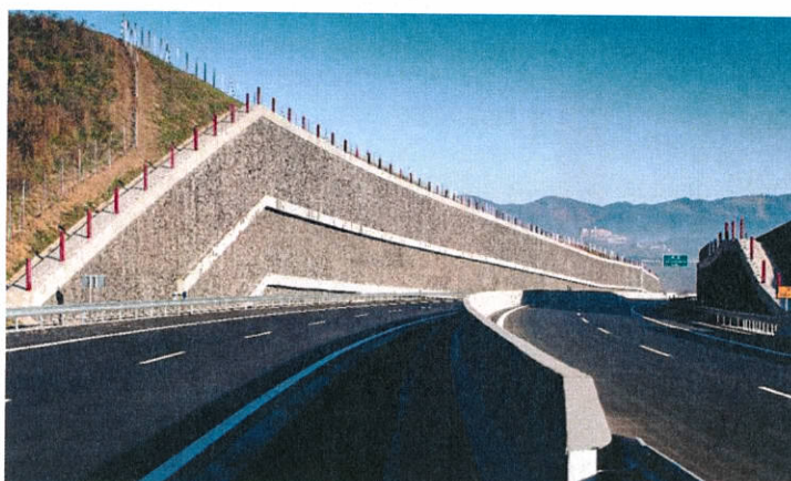
Diaľnica D1 v úseku Jánovce - Jablonov
