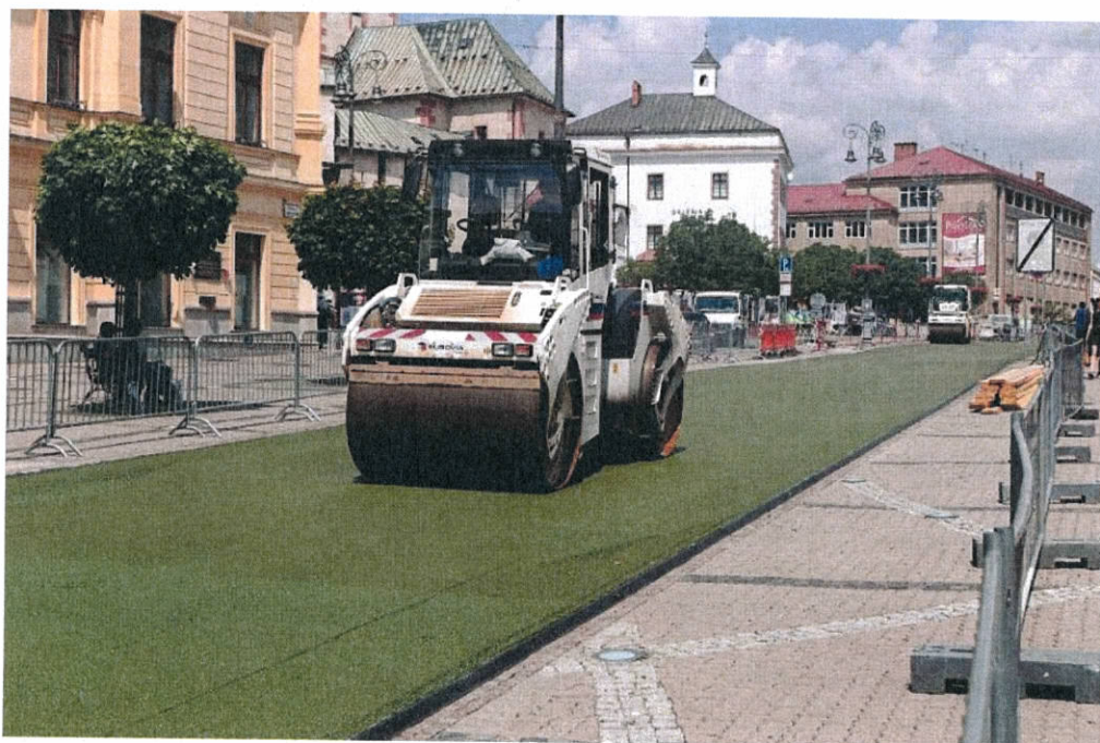
Pokládka zeleného asfaltu v meste Banská Bystrica
