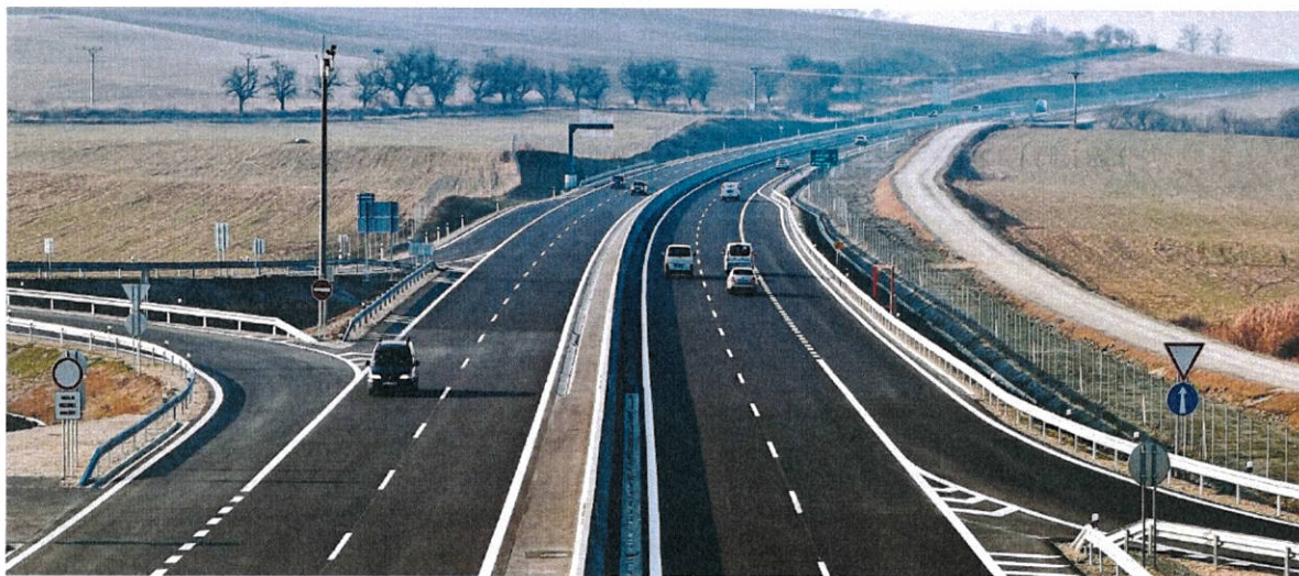
Stavba PPP R1 Nitra – Tekovské Nemce, križovatka Beladice
