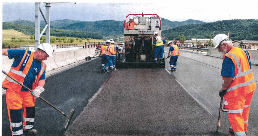
Pokládka emulzného mikrokoberca GRIPFIBRE na D1 Behárovce
