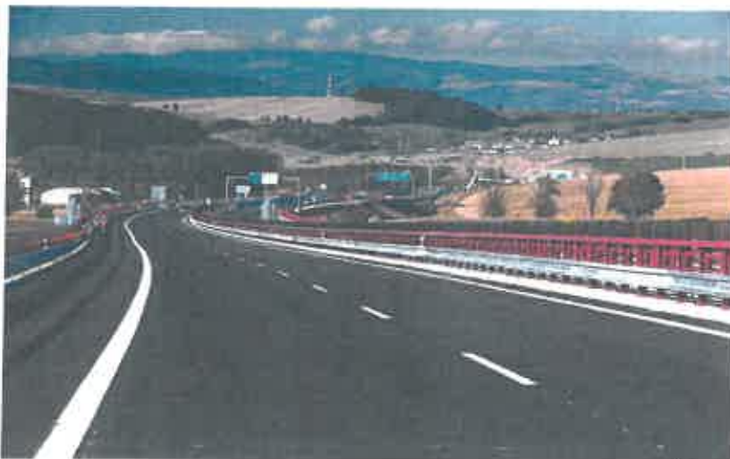
Stavba Diaľnica D1 v úseku Janovce - Jablonov
