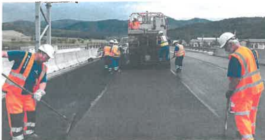
Pokládka emulzného mikrokoberca GRIPFIBRE na D1 Behárovce
