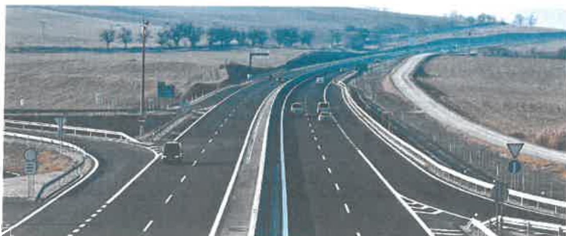
Stavba PPP R1 Nitra – Iekovské Nemce, križovatka Beladice
