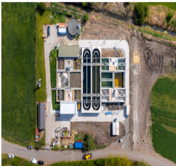
Rozšírenie ČOV Gaiarv
