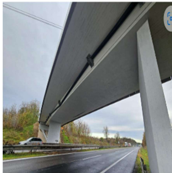
Zosilnenie Nosnej Konštrukcie Mosta Ev. Č. 1109-001
