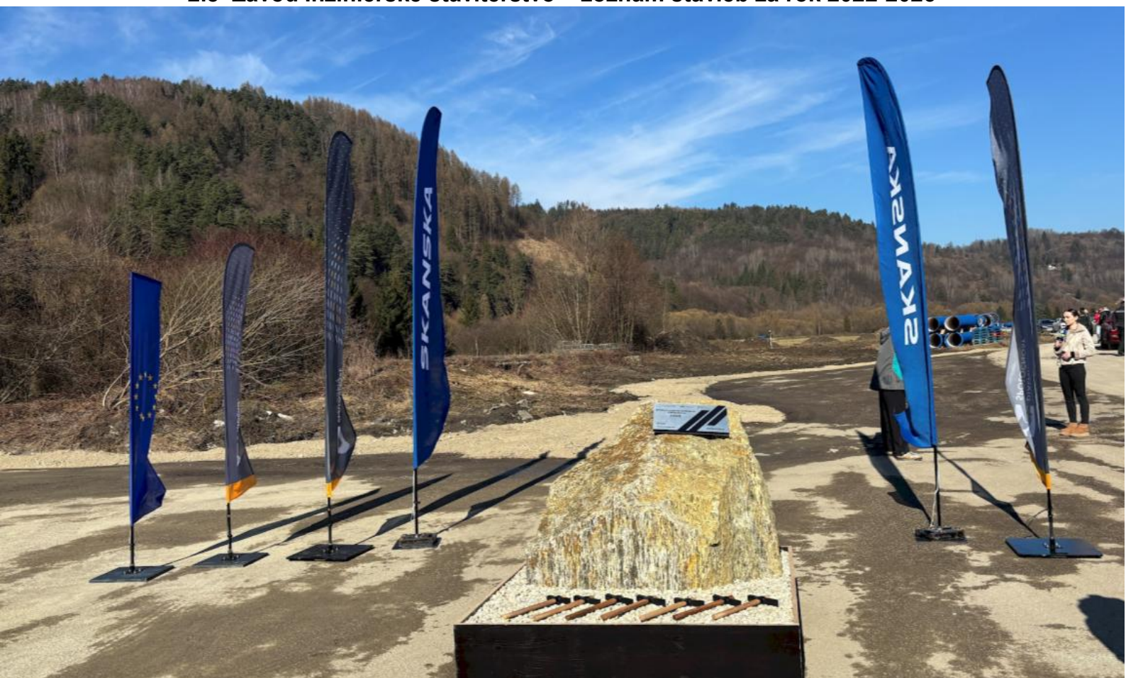
Poklepanie základného kameňa Diaľnica D3 medzi Kysuckým Novým Mestom a Oščadnicou
