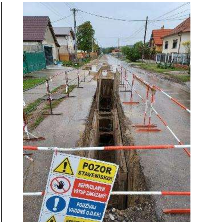
Kanalizácia Lúča na Ostrove
