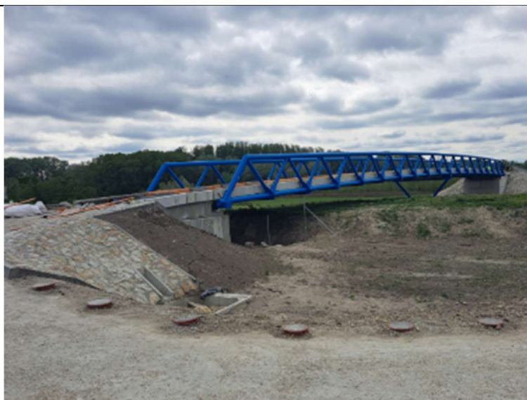
Výstavba mosta pre peších a cyklistov Dobrohošť - Dunakiliti
