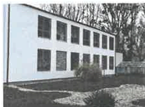
Rekonštrukcia V.ZŠ, Michalovce
