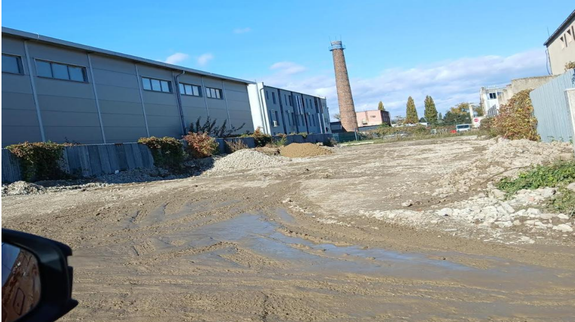
Obr. 4 Zhromažďovanie recyklátov – betónový recyklát, triedená zemina...
