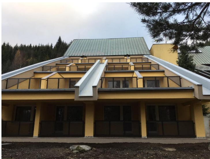
Hasičská zbrojnica, Obec Leštiny - Stavebné úpravy
