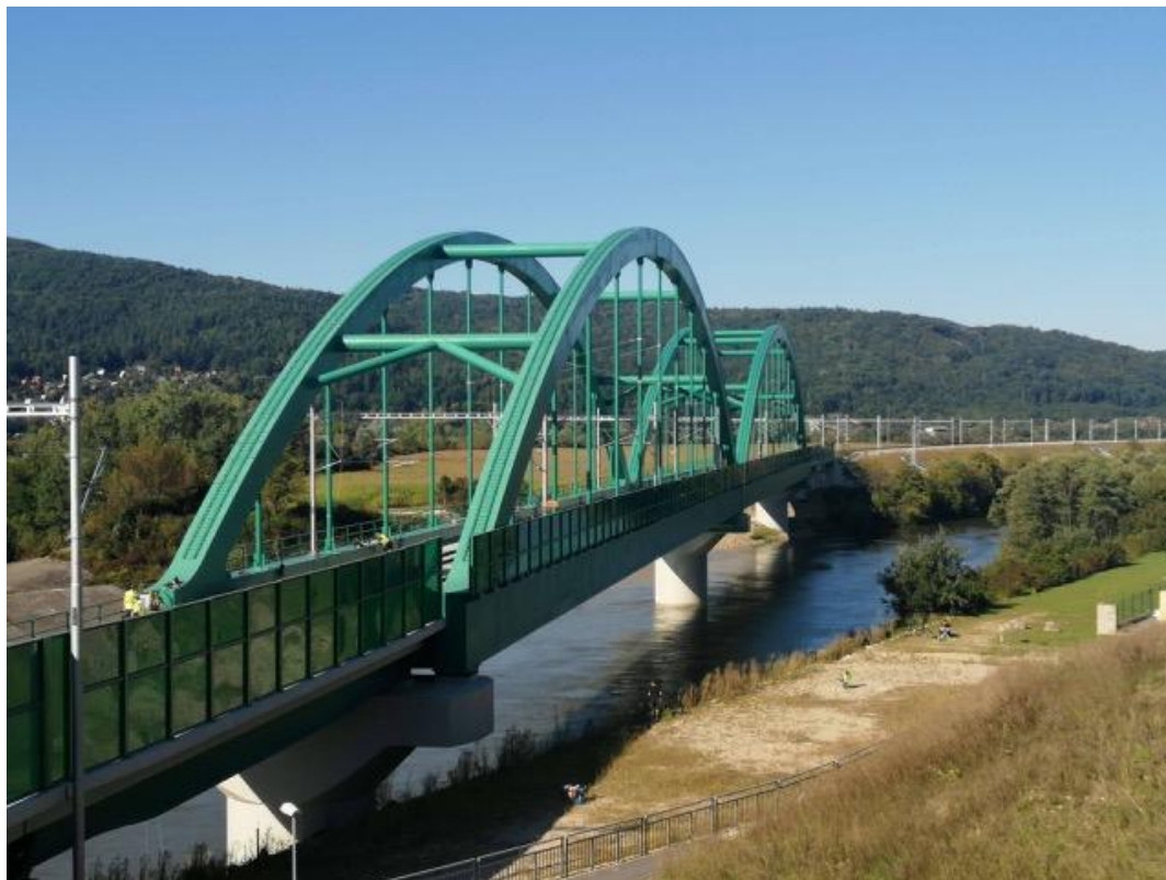
Stavba mosta Púchov
