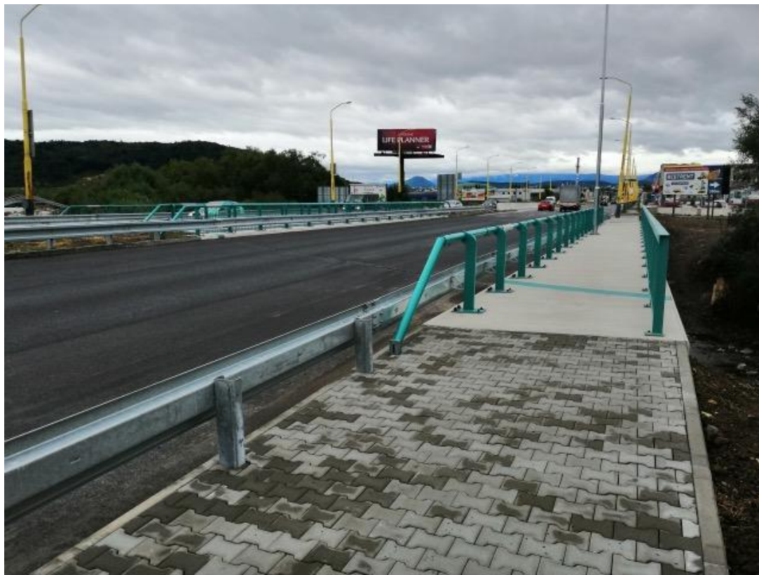
Stavba mosta Prešov
