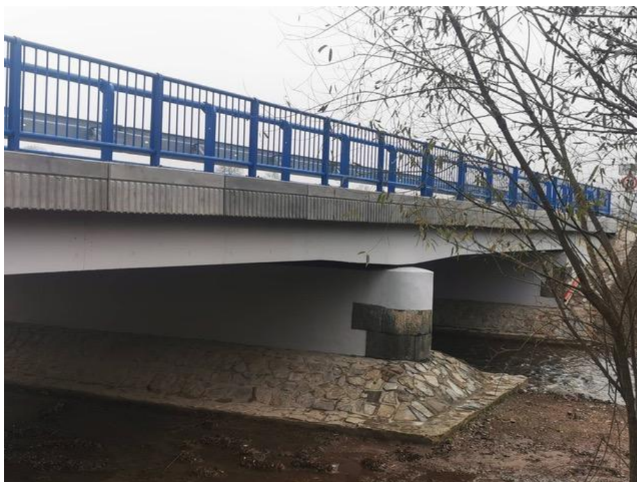
Stavba mosta Smilno - Svidník
