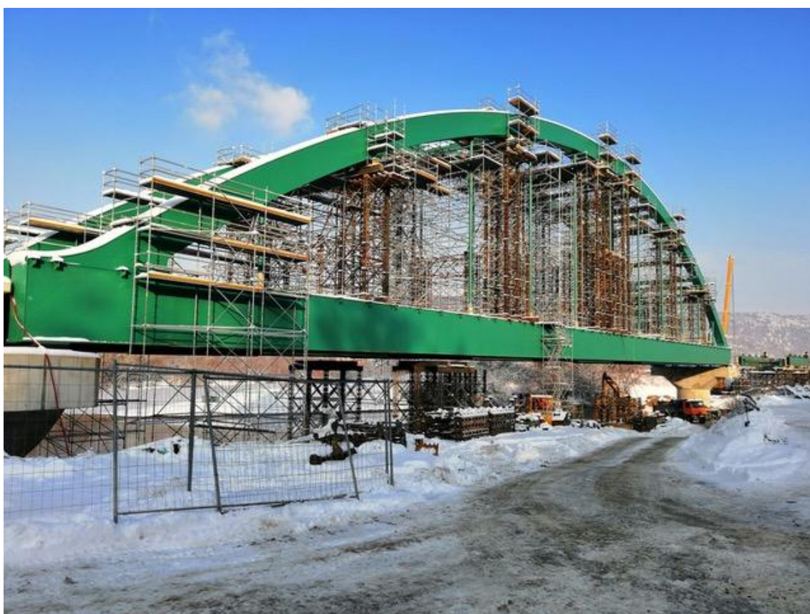
Stavba mosta Púchov
