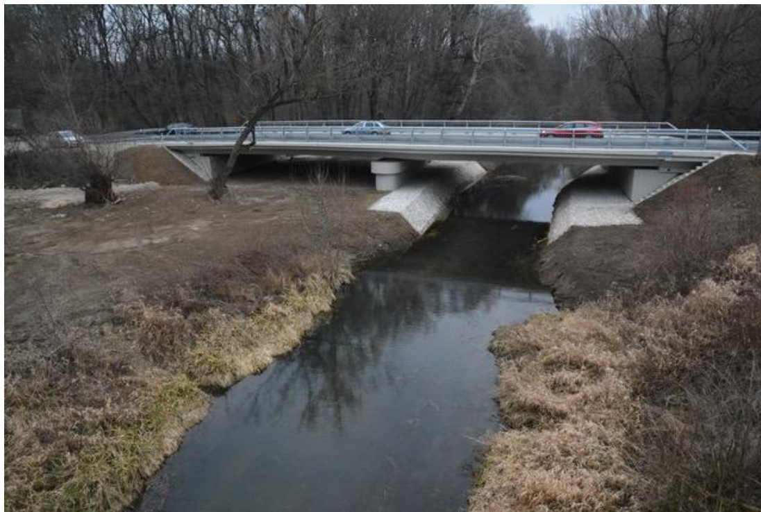
Stavba mosta Holič
