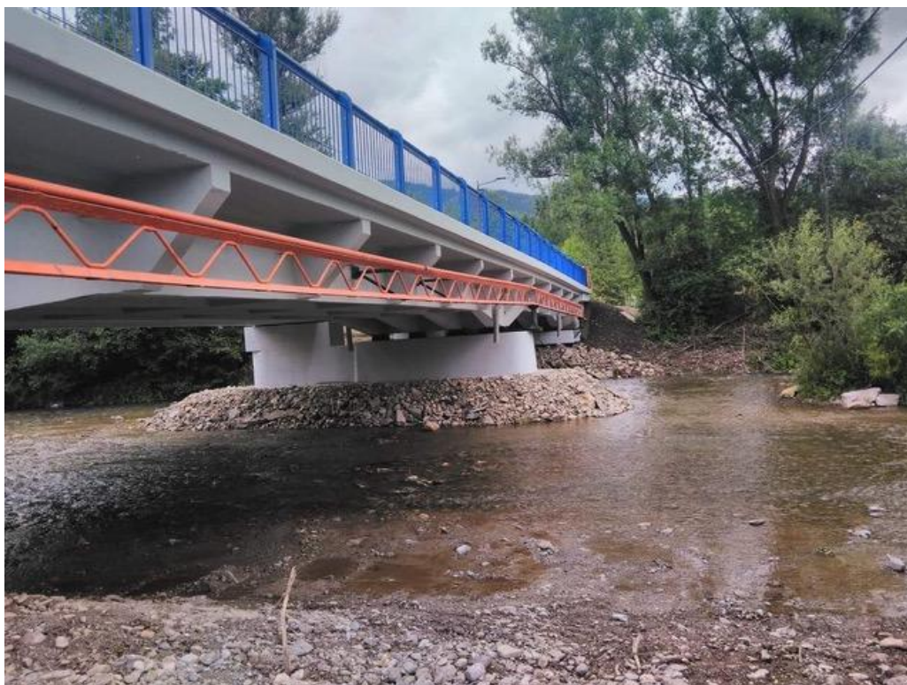
Stavba mosta cez rieku Varinka
