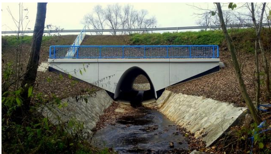
Stavba mosta Smilno Svidník
