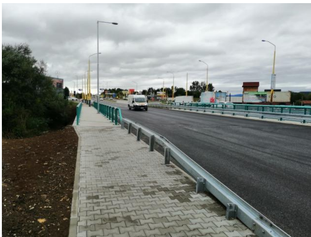
Stavba mosta Prešov
