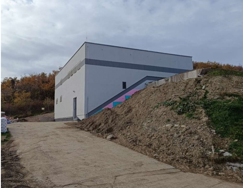
Obrázok 1 – Grinava, rekonštrukcia vodojemu
